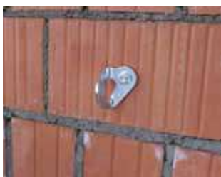
Анкерная точка в кирпичной стене.
