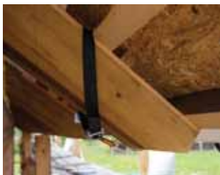
Анкерная точка вокруг стропильной ноги.
