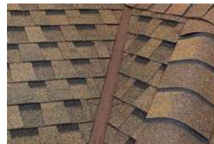
Калифорнийская ендова (один из вариантов открытого способа)
